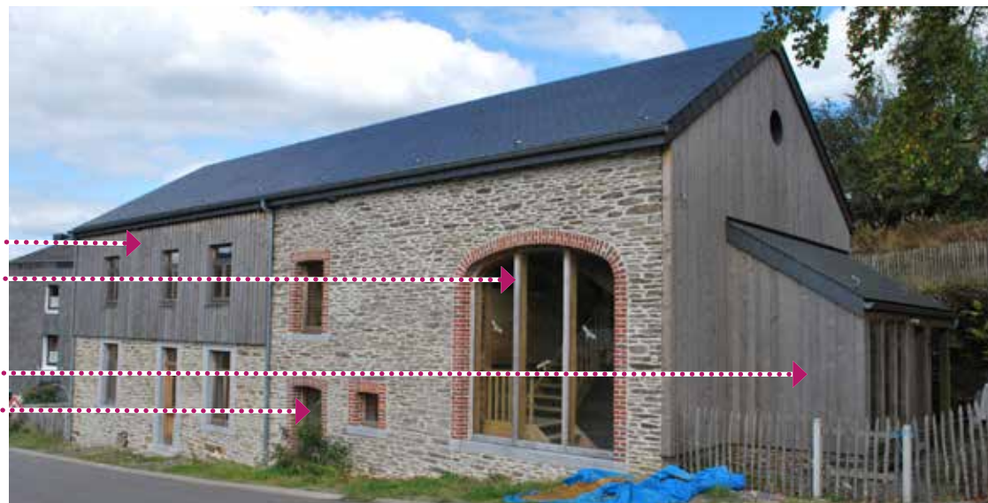
DES DÉPENDANCES AMÉNAGÉES EN PIÈCES DE VIE
