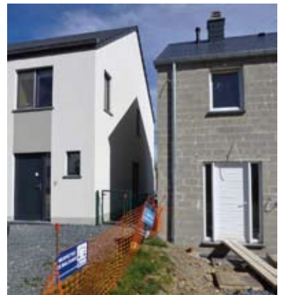
Intimité des logements : problème des vis à vis
