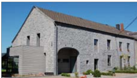
Réaffectation d'une ferme en plusieurs logements.
