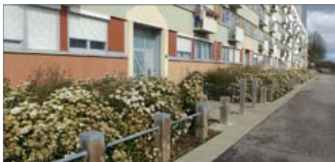
Des barres de logement existantes améliorées et leurs pieds d'immeubles verdurisés.
