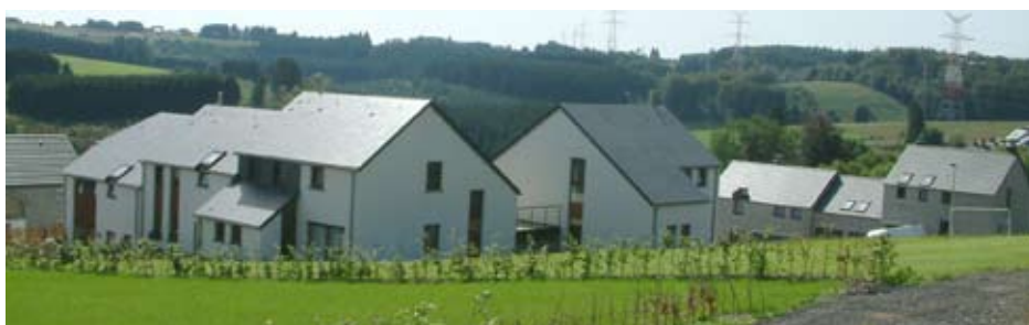
Une vue arrière des logements à flanc de colline
