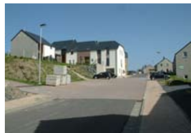
L'ancrage des logements dans l'espace-rue grâce au pignon implanté sur l'alignement
