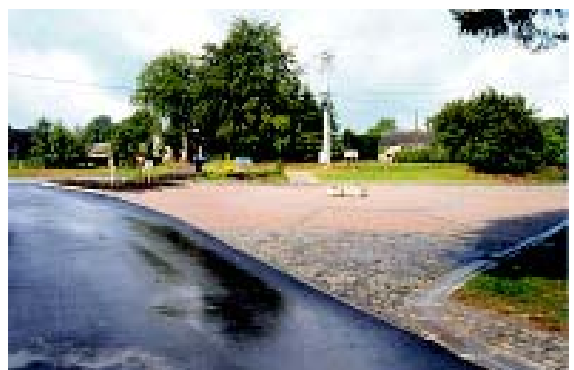
Aménagement de sécurité routière et valorisation du cadre de vie à Walk (Waimès)
