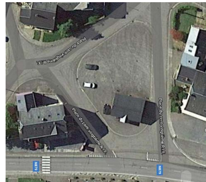
Place de Bellefontaine avant travaux
