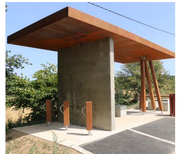
Abribus à Jalhay - ©FRW
